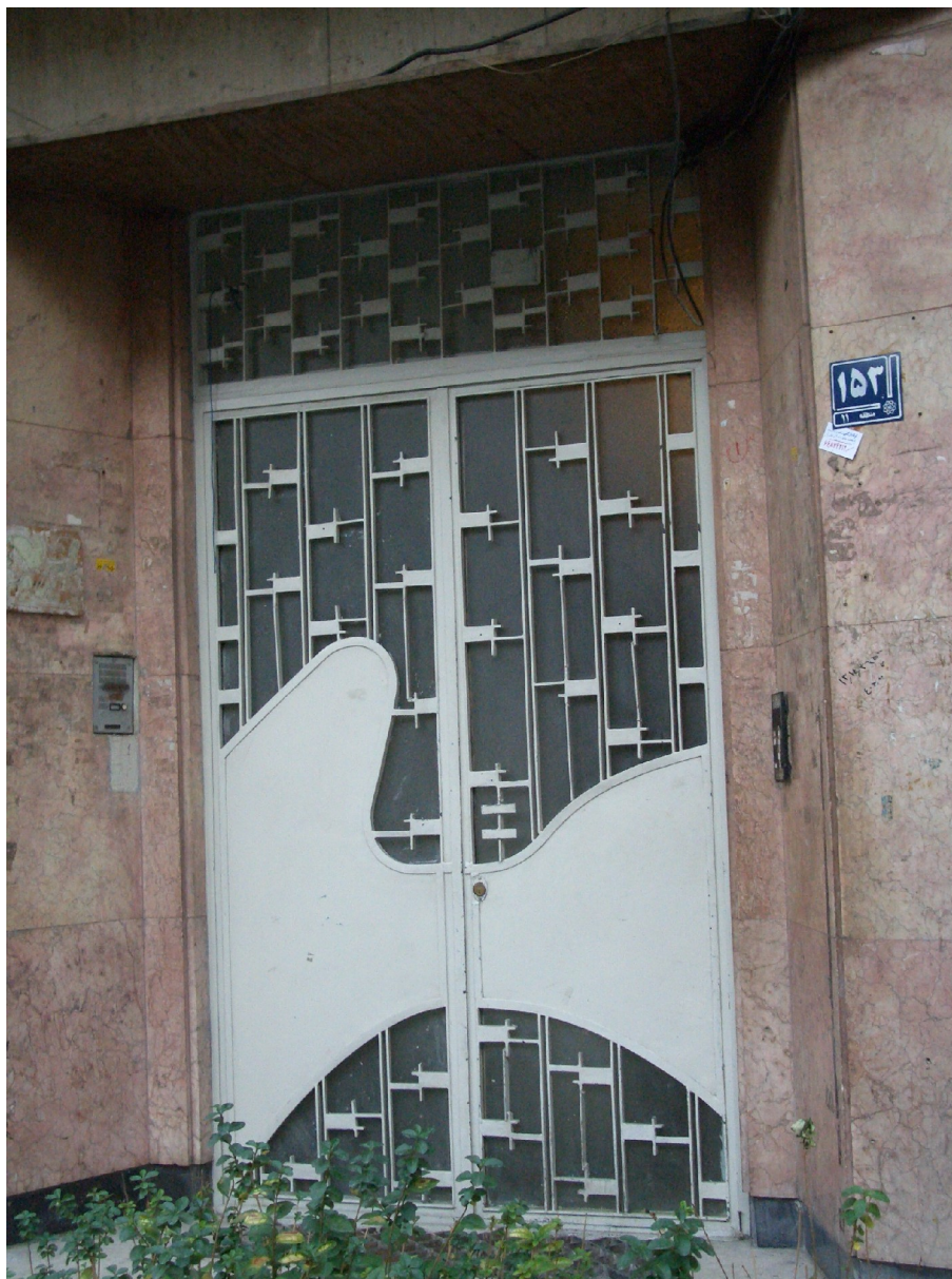
نمایی از در ورودی خانه تقاطع گلشن و نشاط
